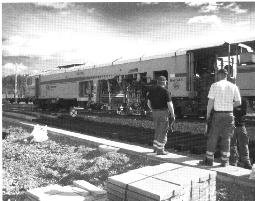
Spårläggningen utfördes i snabbt tempo med stora specialmaskiner.
